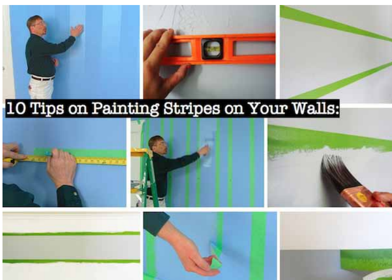
Con livella, metro e nastro carta si ottengono strisce di ogni genere.
